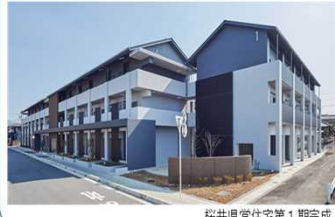
桜井県営住宅第1期完成
