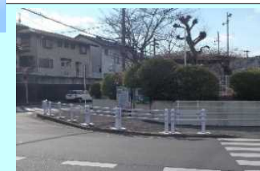
防護柵の設置
